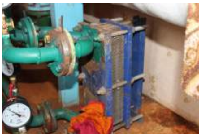
Рис. 14.10. Теплообменник пластинчатый ГВС
