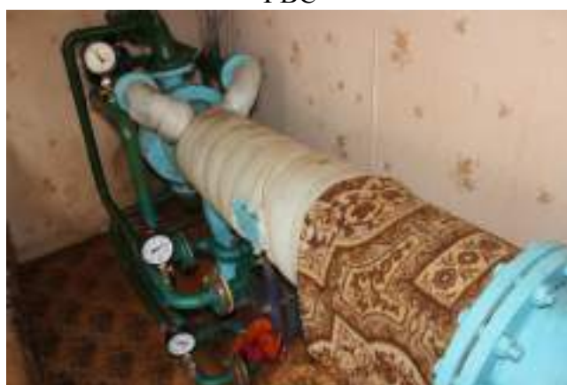
Рис. 14.11. Теплообменник кожухотрубный ГВС
